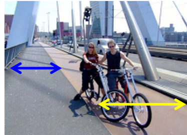
Erasmusbrug Rotterdam, Netherlands
